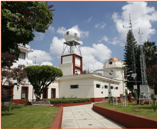
Instalaciones del Instituto de Astronomía y Meteorología, Patrimonio Cultural de Jalisco, en funcionamiento continuo desde al menos el año de 1894.
