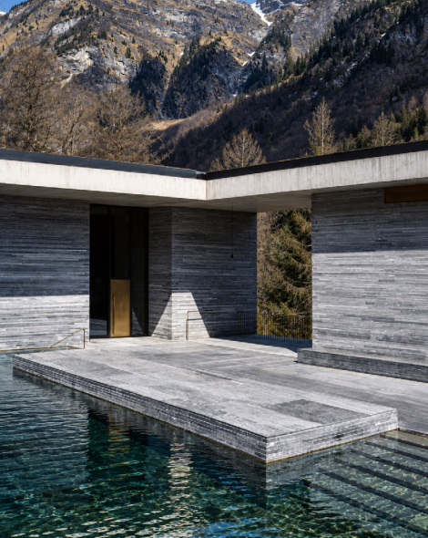
Complejo Termas de Vals / Construcción 1993-1996.
